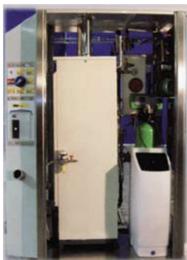
OSNOVNI MODUL voda/energija uključujući omekšavanje
